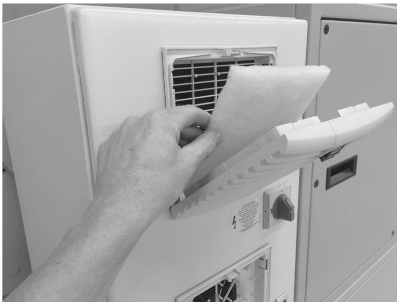
Fig. 57 : remplacement du filtre armoire de commande
